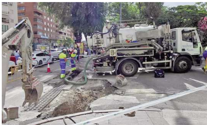
Trabajos para reparar los daños de la tormenta del pasado martes en Jaén. AYUNTAMIENTO DE JAÉN
